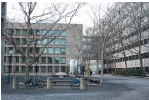
Рис. 5. Центральная часть кампуса MIT в Кембридже (США)
